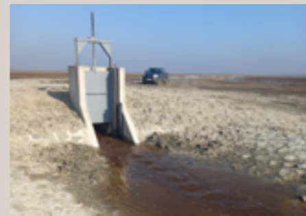
Hat zsilip épült újjá, és egy teljesen új zsilip is készült a Bűdös-széki-csatornába becsatlakozó Vesszősi-csatorna torkolatánál (fotó: Pataki Zsolt)
